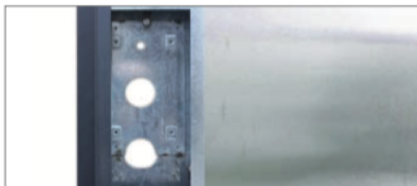
PIASTRE DI PROTEZIONE IN ACCIAIO DA 20 DECIMI SU SERRATURA E DISPOSITIVI
